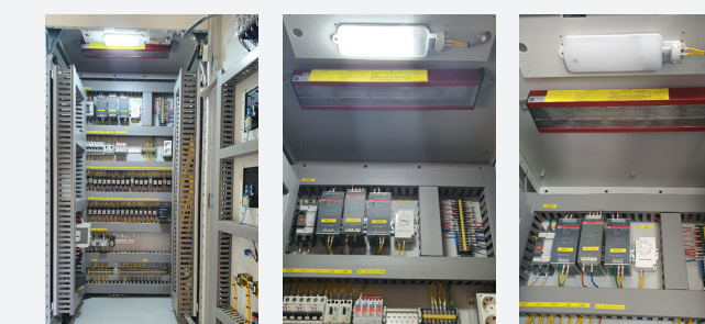
天安木川加圧場テストベッド進行中(無人事業場) (インバーター-PNL No.1&No.2) 設置
